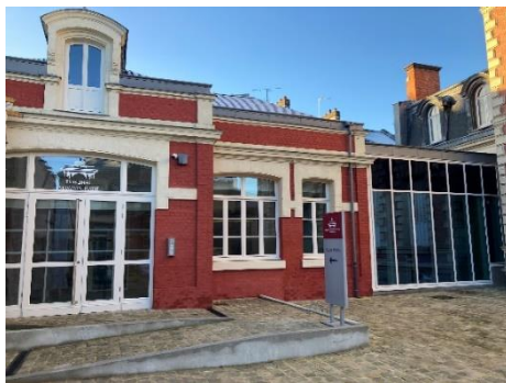
Vue de la façade de l'annexe A du tribunal
